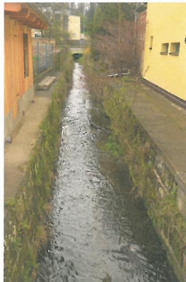
pohled na obtížně přístupný úsek mezi ř.km 0,86 a 1,02 ze zdiva vyrůstají dřeviny
