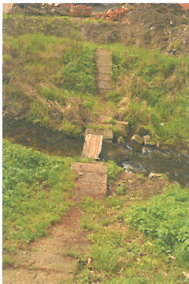
zbytky stabilizačního prahu v ř.km 1,15
