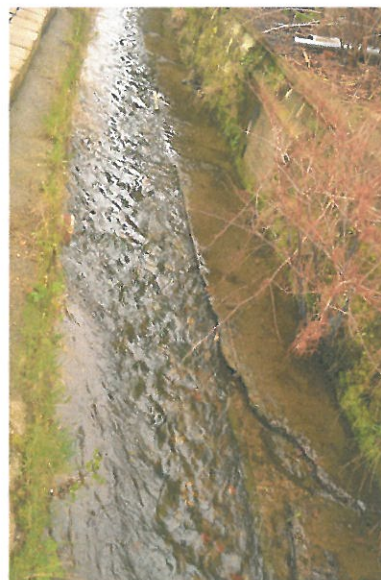
rozbité opevnění dna v úseku ř.km 0,86 - 1,02
